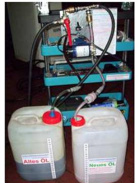
**oder** Restliches **Neues Öl** einpumpen. **12V Ölpumpe** ausschalten. **10 Liter Neues Öl** eingepumpt bei **großem Wärmetauscher**. Ölstandskontrolle ca. **55°**. Korrektur mit dem System,
